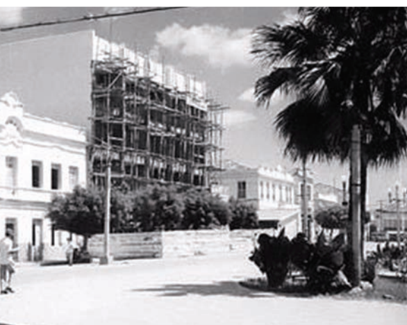
Construção do Esperança Palace Hotel, nos anos 1960
