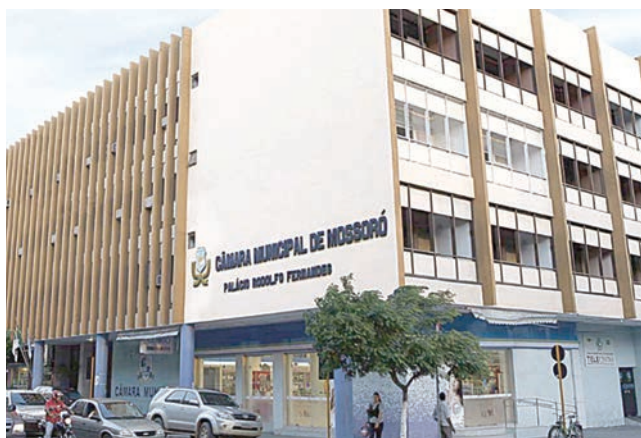
Câmara Municipal de Mossoró funciona no prédio do antigo hotel desde março de 1993
