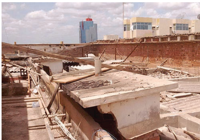
Telhado do prédio necessita de concertos
