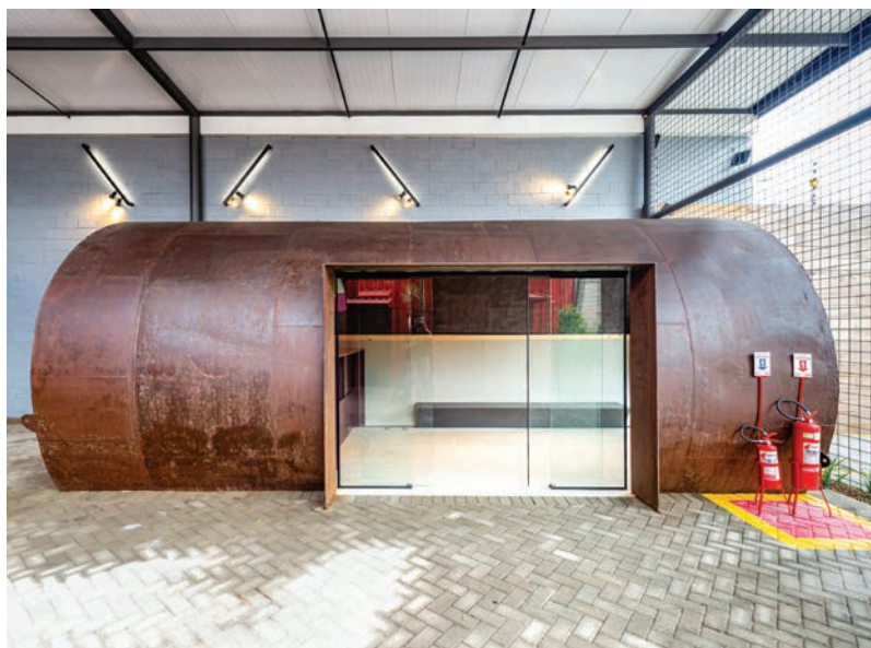
Silo foi transformado em doceria
