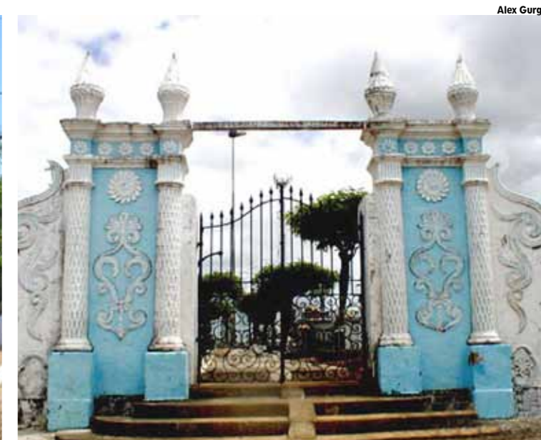
Fachada do cemitério
