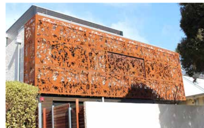
Fachada com placas metálicas irregulares
