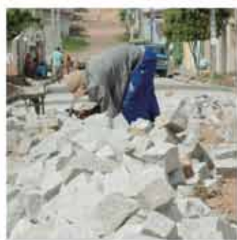
Pavimentação da Rua General Leco
