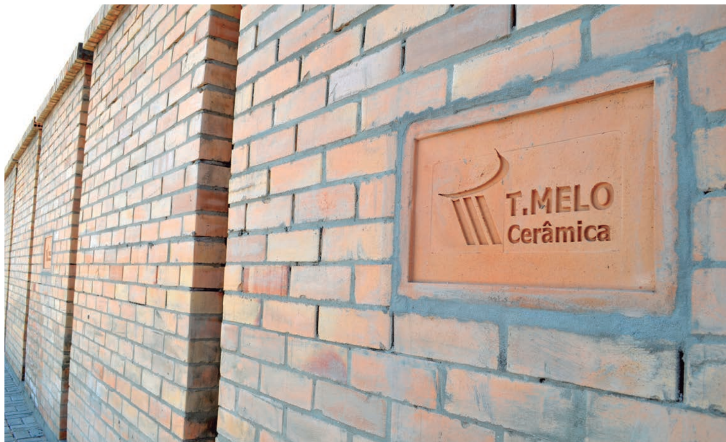
Fachada do Aeroclube reformada com tijolos aparente
