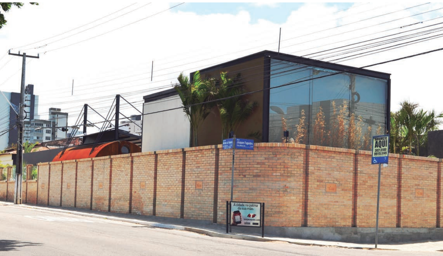
Fachada construída com produtos sustentáveis da T Melo
