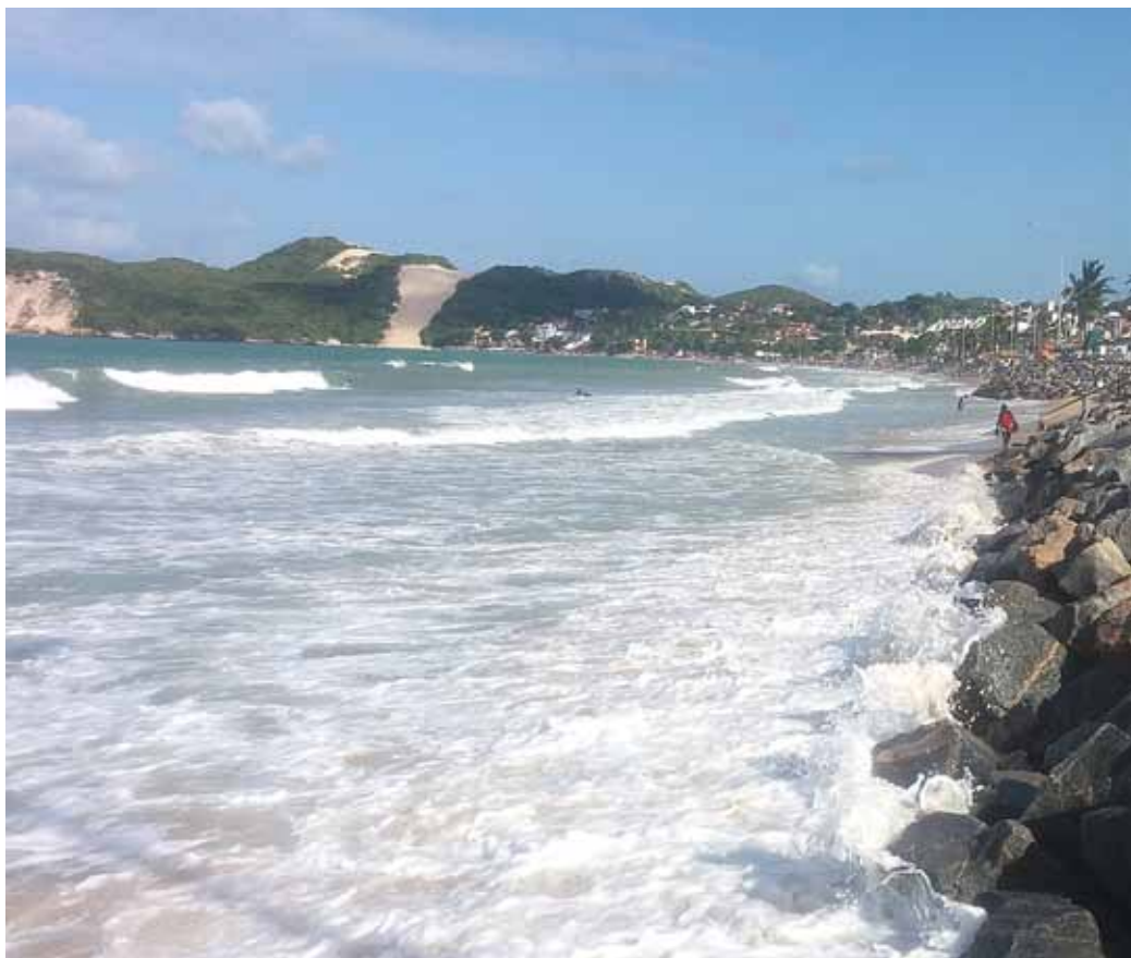
Praia de Ponta Negra depois da obra de enrocamento
