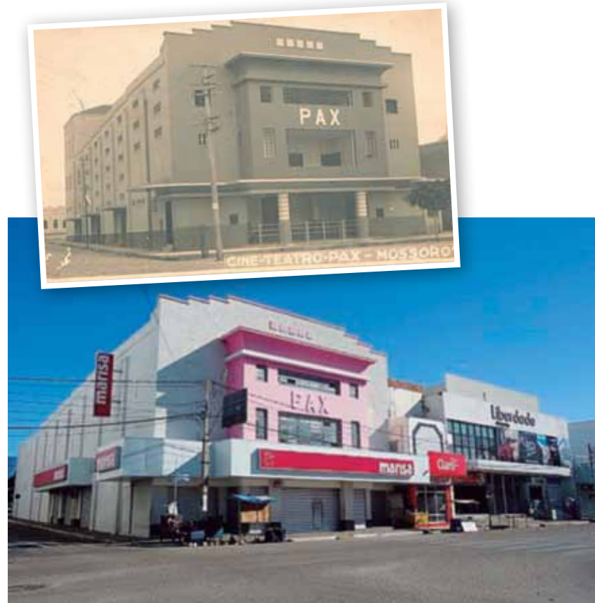
O cinema PAX, que resistiu por várias décadas, abriga uma grande loja
