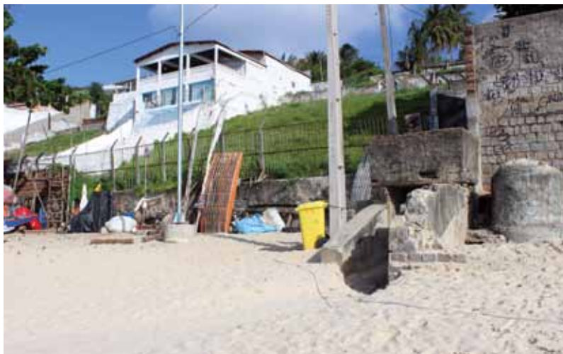
No caminho para o Morro do Careca, esgoto na orla
