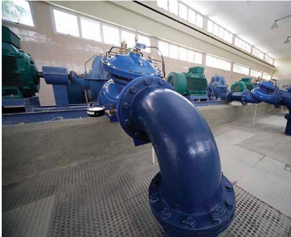
Estação de Tratamento do Jiqui, no Rio Grande do Norte
