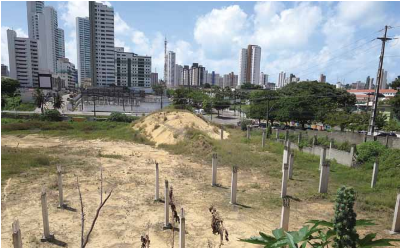
No terreno, jazem os pilares da construção abandonada
