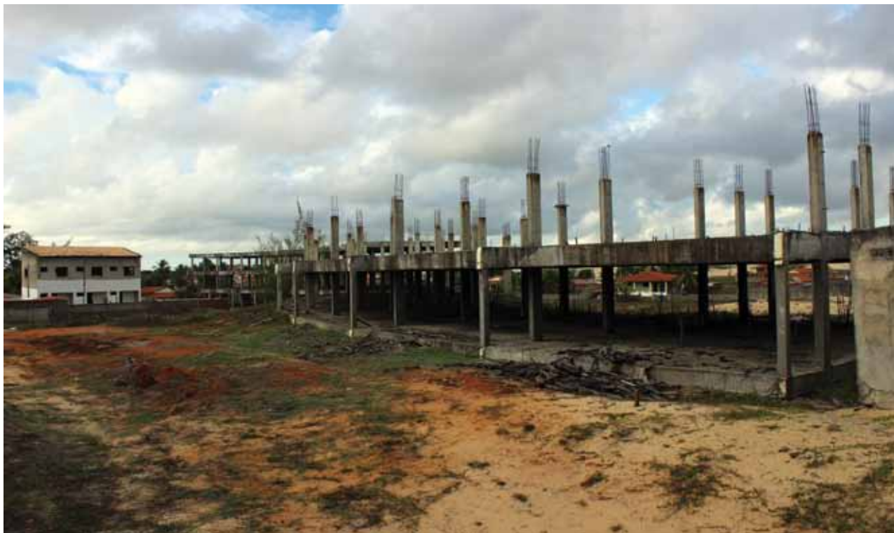
Resort construído ao lado de residências foi embargado por ocupar área de preservação
