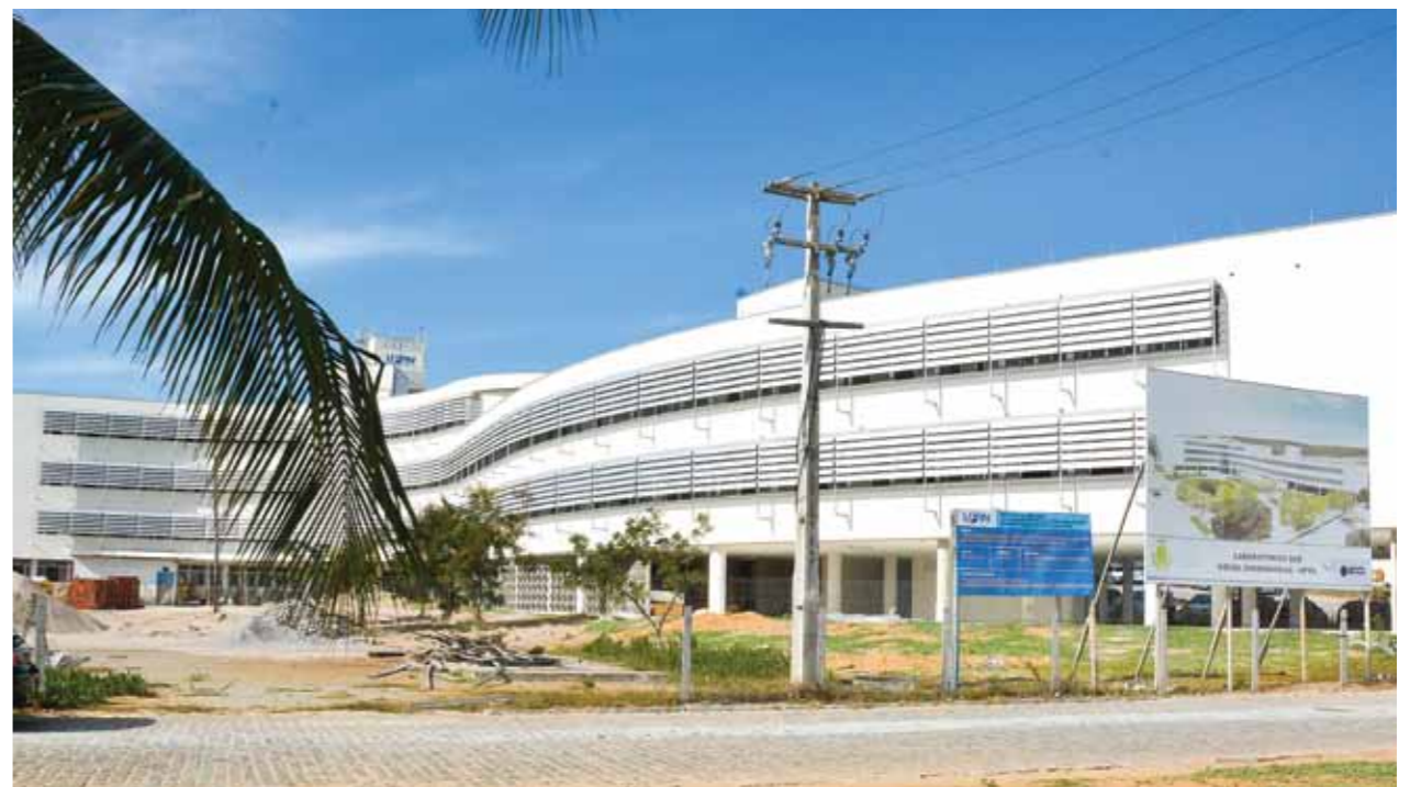
Prédio abrigará os modernos laboratórios de engenharia
