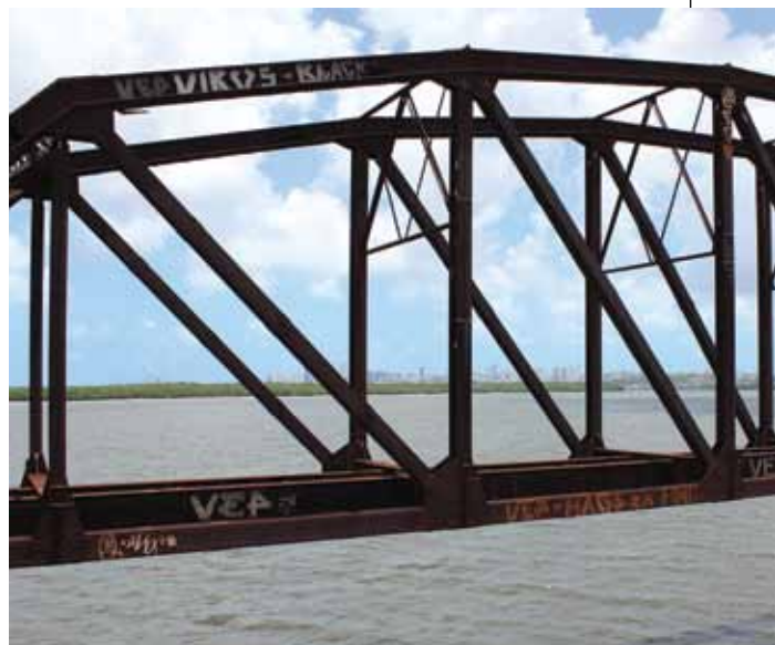
Consequências do abandono: parte do monumento prestes a ruir
