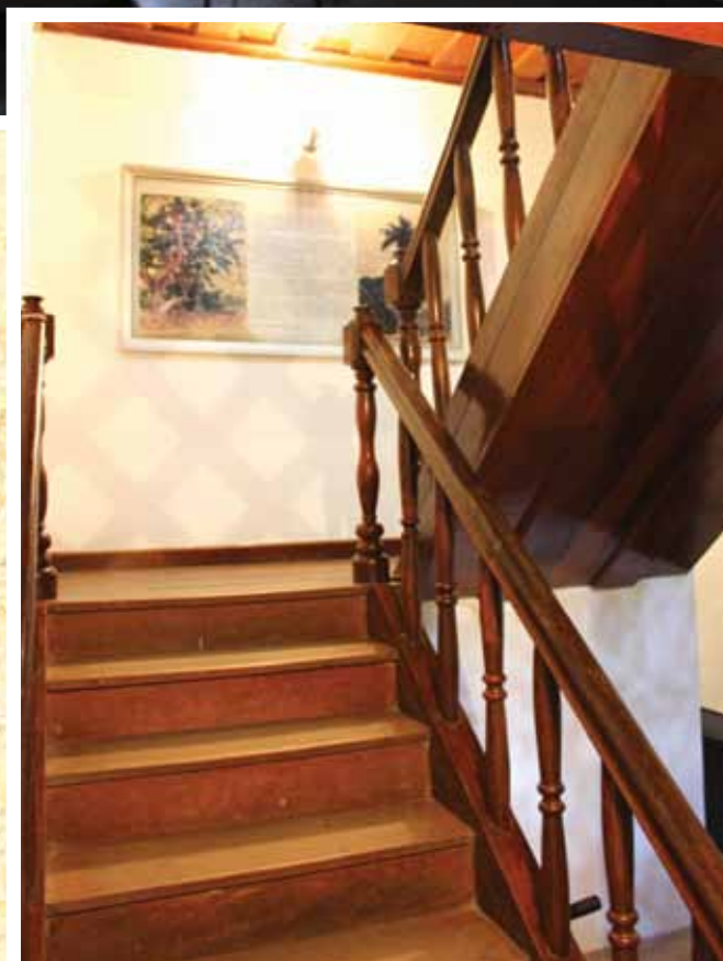
O piso de madeira comprometido pelo cupim
