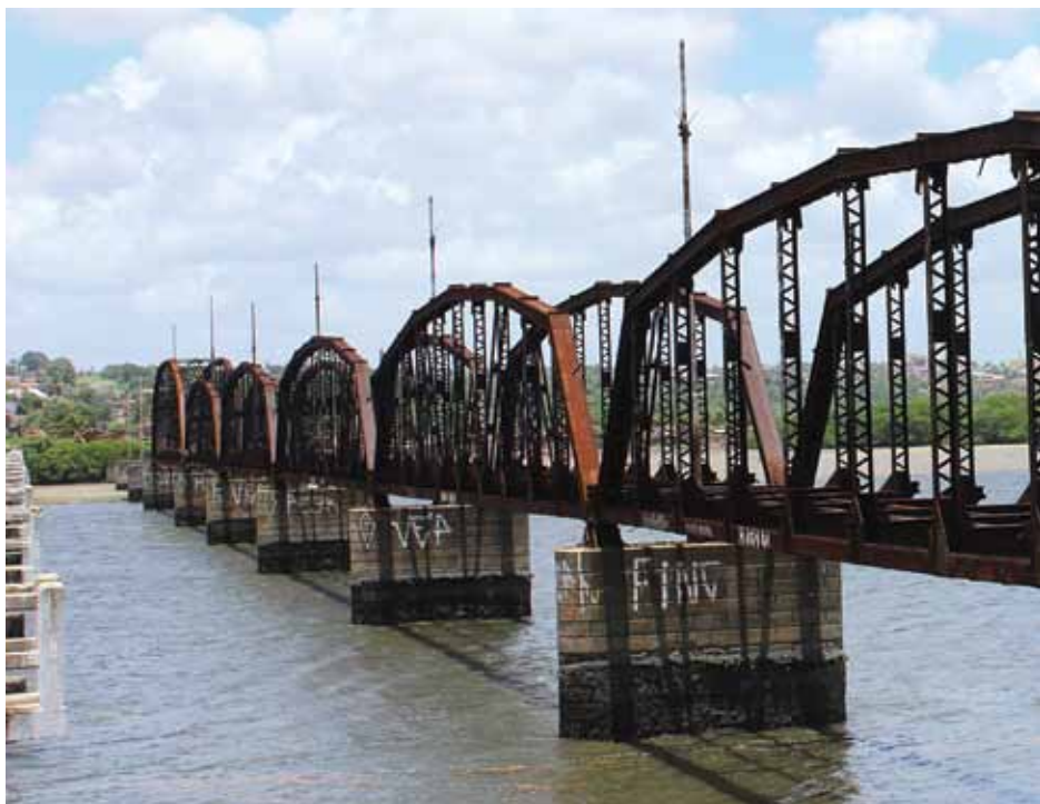
Acima, a “casa” da Catita e abaixo ponte de ferro, ambas abandonadas
