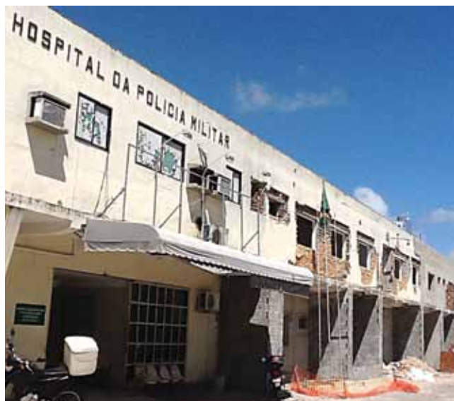
Estrutura mostra a necessidade de reforma
