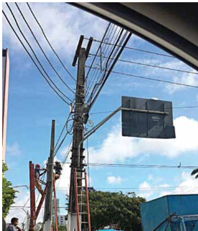
Flagra na Av. Hermes da Fonseca: passam o fio de um lado a outro na principal via da cidade, no bairro de Petrópolis
