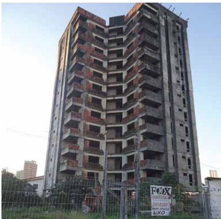
Obra lançada na década de 1990 por uma empresa cearense
