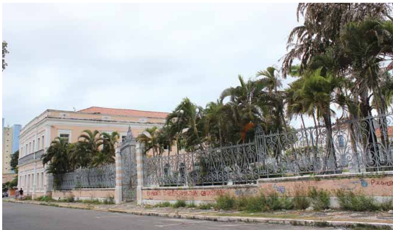
Paredes pichadas e mato agriquem o histórico e belo imóvel
