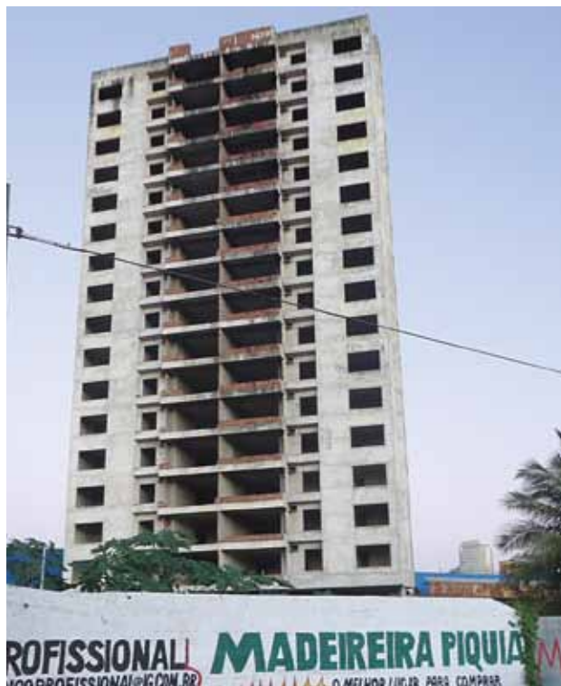
Obra com 32 unidades nunca entregues aos compradores
