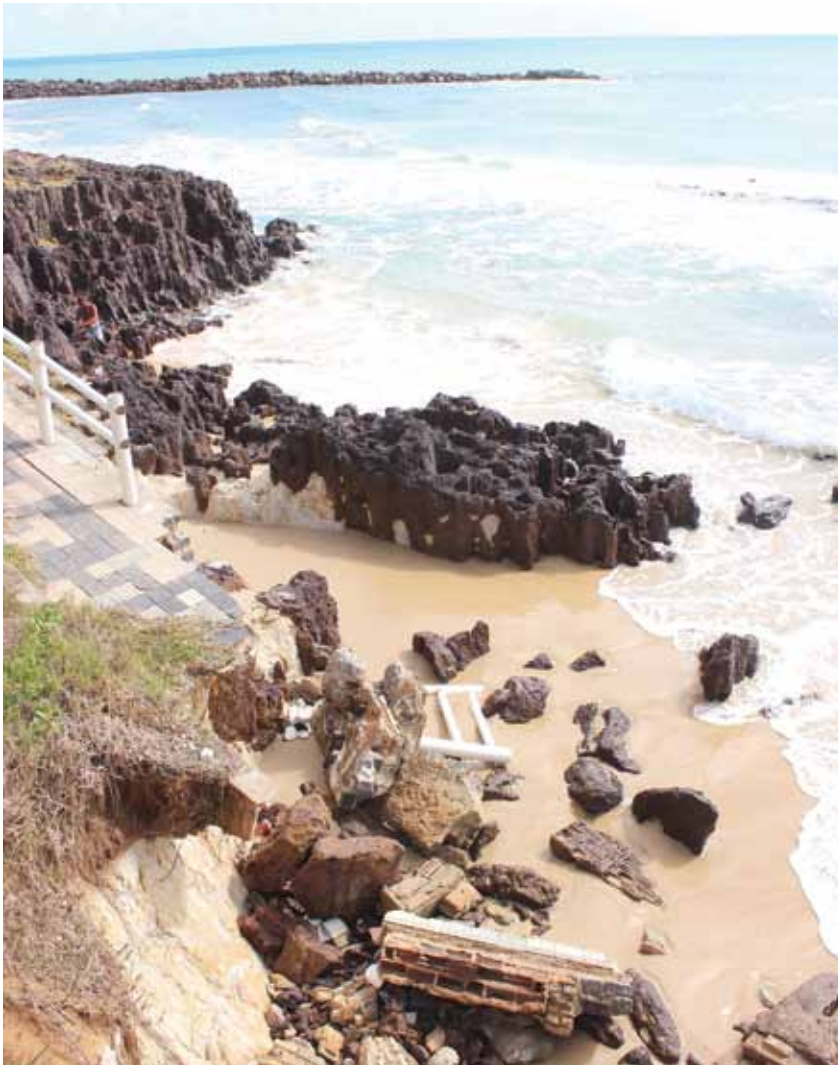
Calçadão destruído na Praia de Miami
