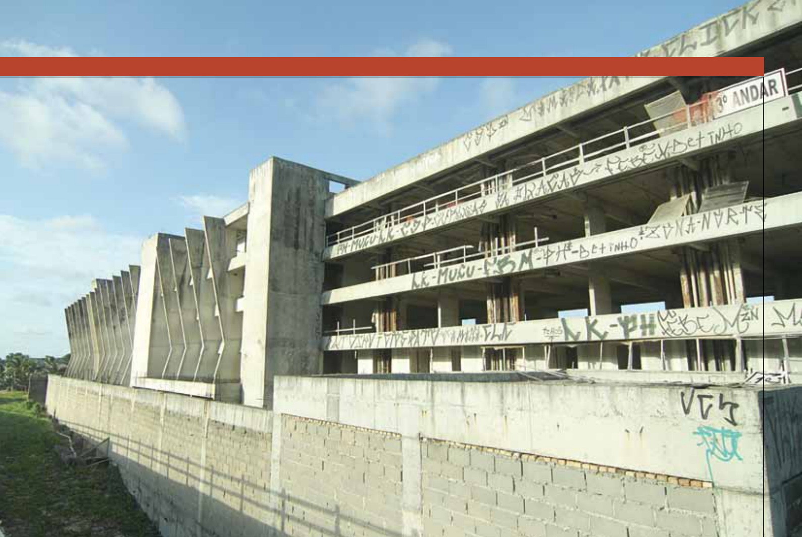
Construção abandonada sofre com a ação de vândalos
