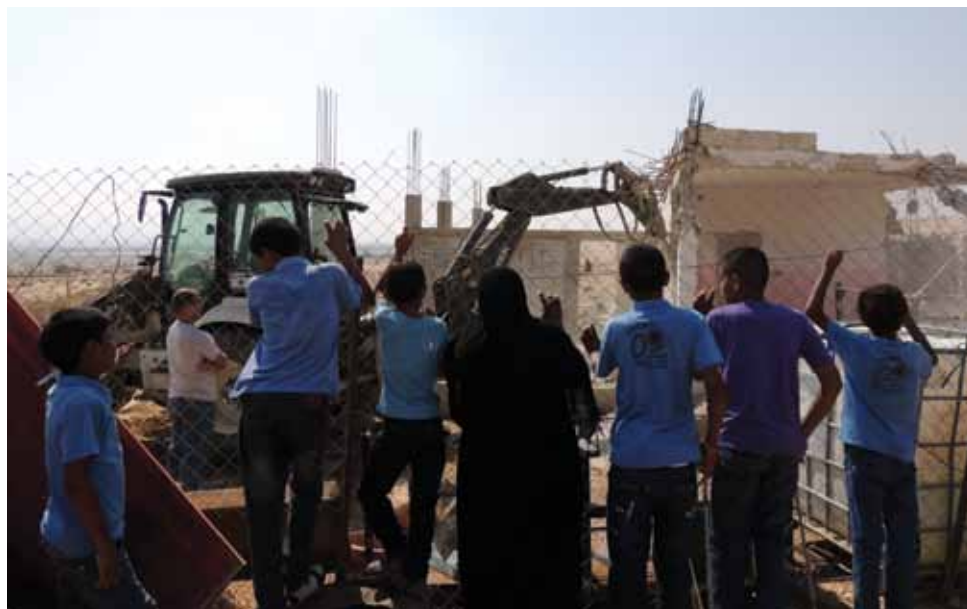
Demolição de casa, por parte de autoridades de Israel, em vila palestina no Vale do Jordão
