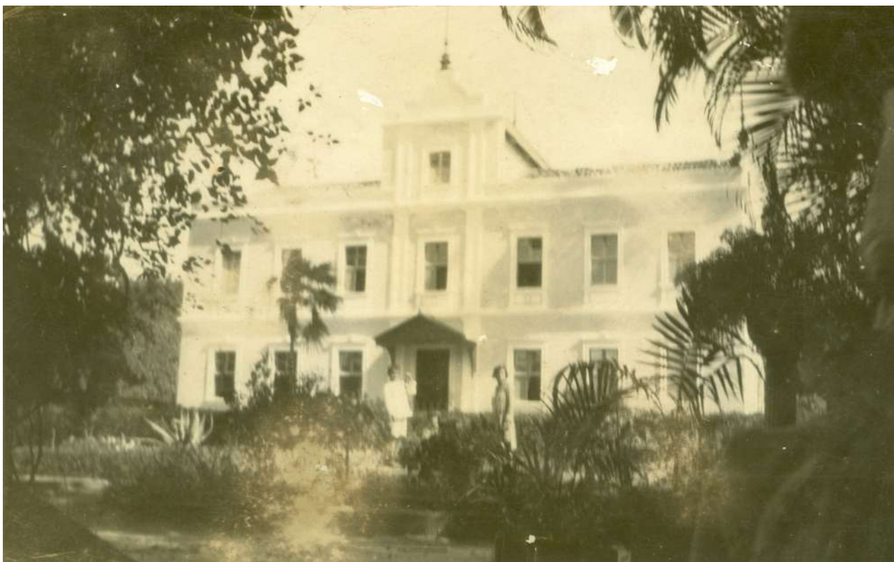
O Solar visto do jardim
