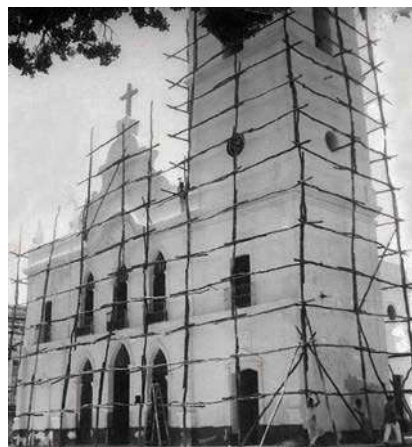
Catedral da capital passou por reparos
