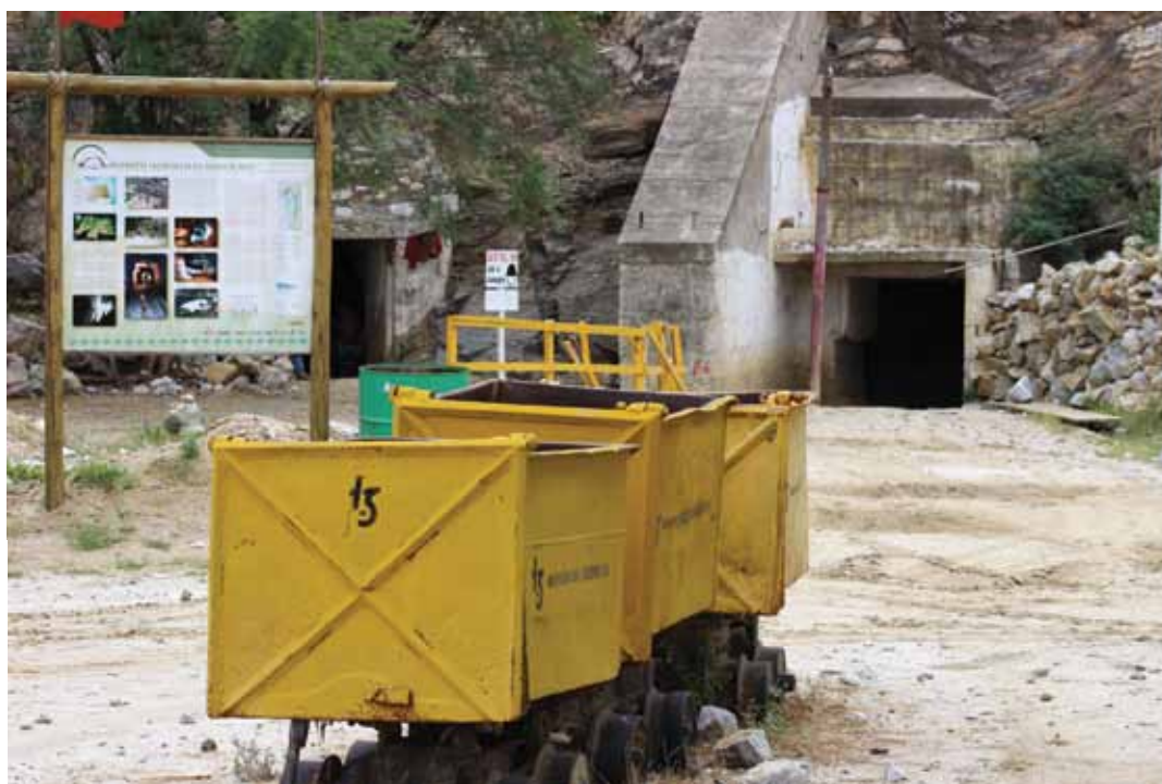
Entrada dos túneis das minas
